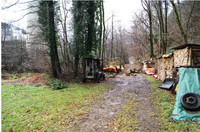
Abb. 18: Übergangsbereich der Verlegungsstrecke auf das bestehende Bachbett. Der links des Weges gelegene Gehölzbestand ist als Waldbiotop geschützt und liegt im Bereich der Verlegung. Betroffen sind hier etwa 15 Roterlen mit Stammdurchmessern bis 50 cm.
