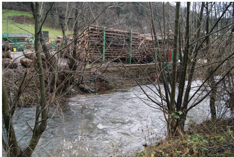
Abb. 10: Reste von Ufermauern im oberhalb der ehem. Wohnhäuser gelegenen Abschnitt
