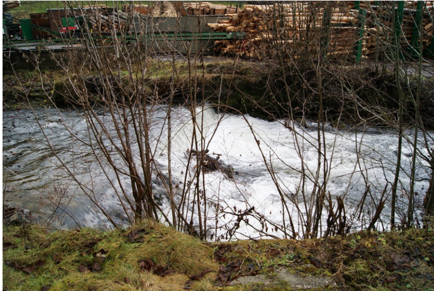
Abb. 11: Der Wehrabsturz unterhalb der ehem. Wohnhäuser
