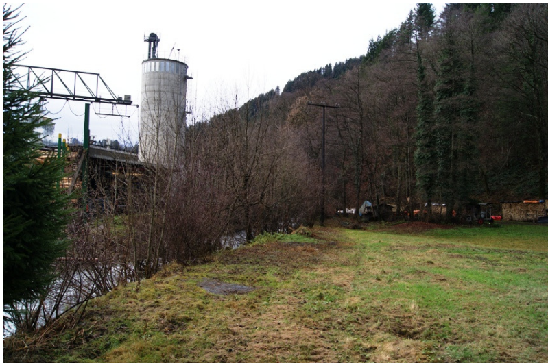
Abb. 19: Anschließender Ufergehölzabschnitt im Einmündungsbereich der Flutmulde. Der Leitungsmast markiert in etwa die Grenze des Waldbiotops.
