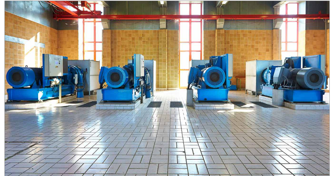
Turboverdichter/Gebläse
