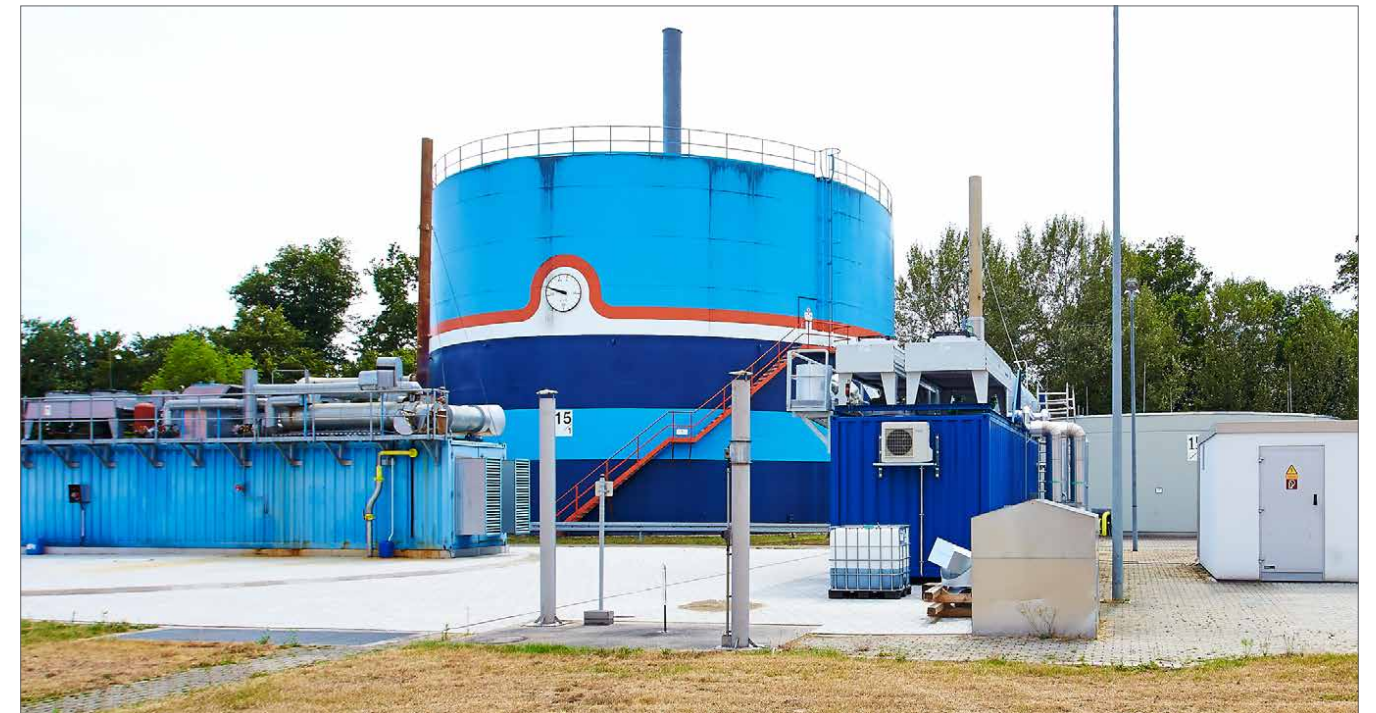
Niederdruckgasbehälter
