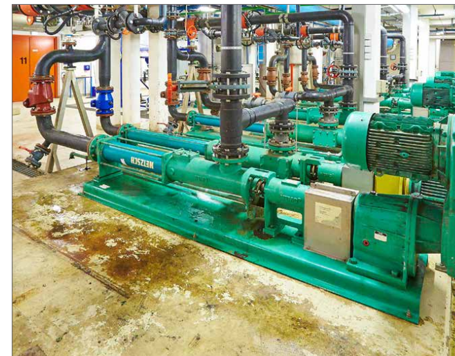
Beschickungspumpen Entwässerung
